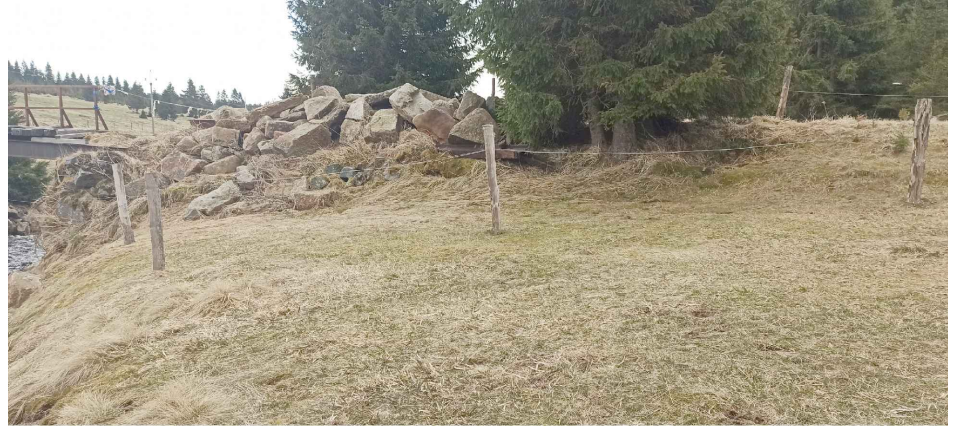
STÁVAJÍCÍ STAV-KÁMEN BUDE VYUŽIT NA OBKLAD OPĚR A TĚŽKY ZÁHOZ V KORYTĚ PŘED OPĚROU
